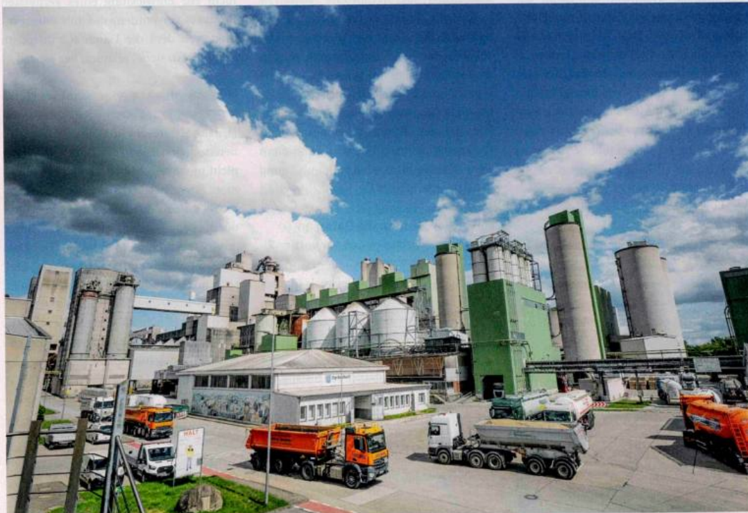
Geschäftiges Treiben beim Zementwerk Lengerich, und doch dunkle Wolken am Horizont: Für die Zementwerke und für den benachbarten Kalkhersteller Calcis ist Dekarbonisierung keine Herausforderung, sondern eine Schraubzwinge: Sie verbrauchen viel Energie, und ihre Prozesse lassen sich nicht komplett dekarbonisieren. Foto: Morsey/IHK
